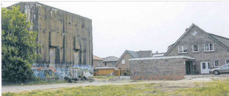
In diesen Bunker am Eisenbahndock kommt das kleine Blockheizkraftwerk, das die Menschen im neuen Stadtteil Neuer Delft im kommenden Jahr versorgen wird. BILD: SCHRÖDER
