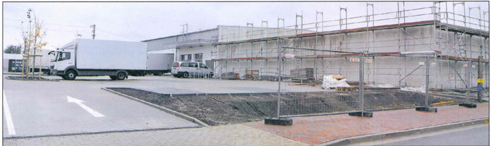
Ab nächste Woche ist der Edeka-Markt geöffnet: Während die Einrichtung auf Hochtouren läuft, stehen die Anbauten für die Fachmärkte noch im Rohbau da. EZ-Bild: Wilken
