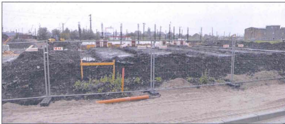
Gründungsarbeiten: Im Osten des Baugebiets wird ein Nahversorgungszentrum entstehen.
