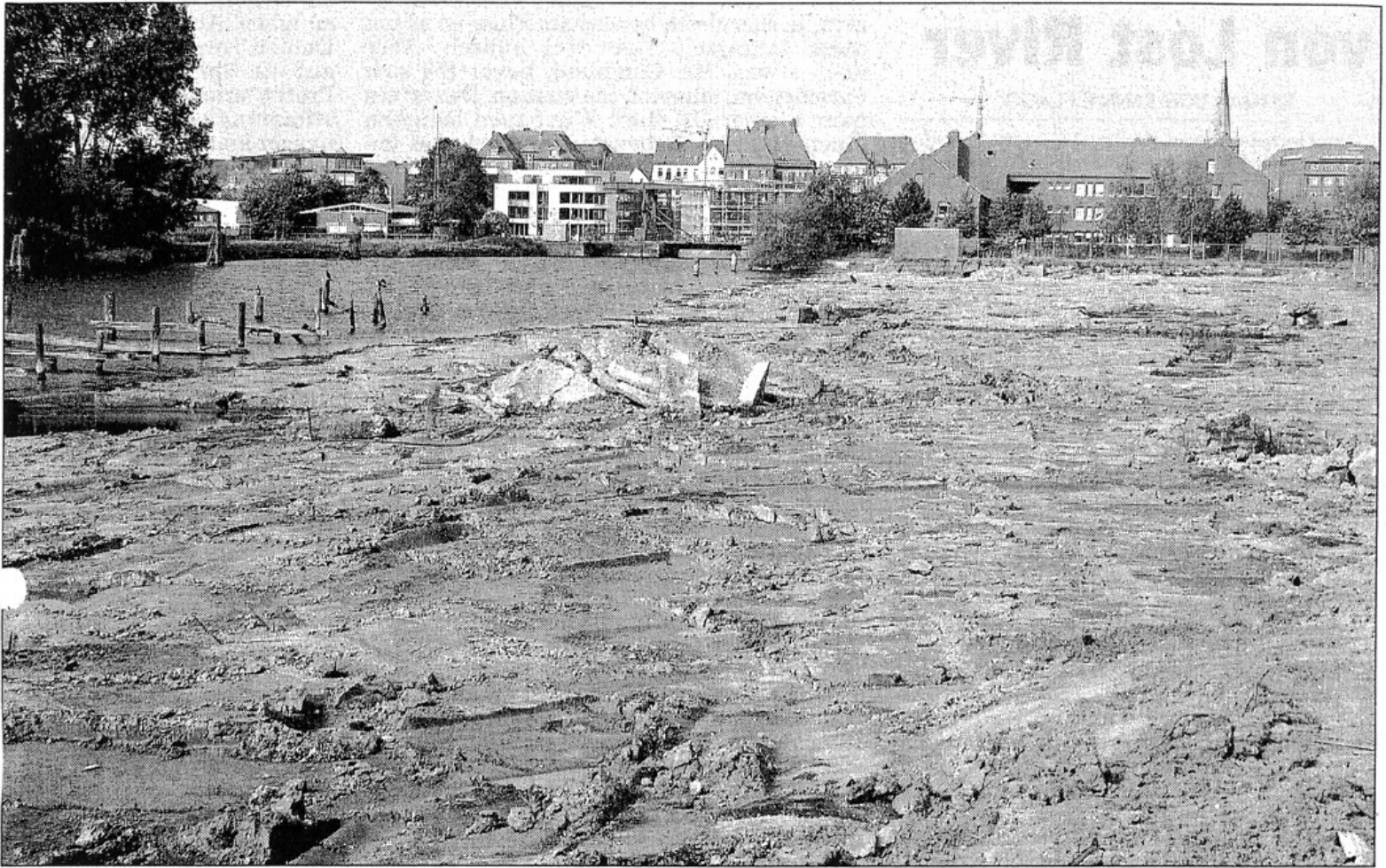
Die Bagger haben ganze Arbeit geleistet: Die alten Baureste auf dem Eisenbahndock-Gelände sind abgeräumt.
