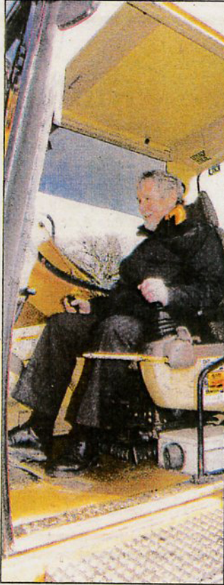
OB Brinkmann mit dem Bagger: Symbolischer „Spatenstich“ am Eisenbahndock.
