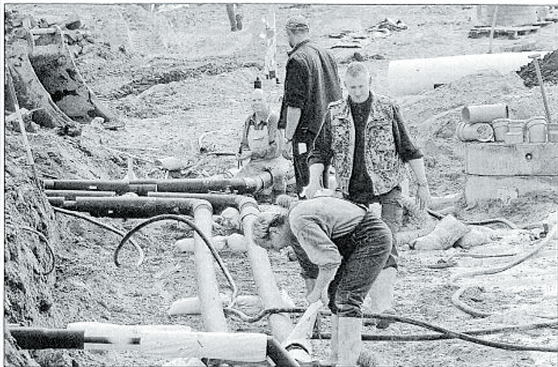
Es geht voran: Am Eisenbahndock entsteht das erste Emdener Baugebiet, das komplett mit einem Nahwärmeversorgungsnetz versehen wird.
