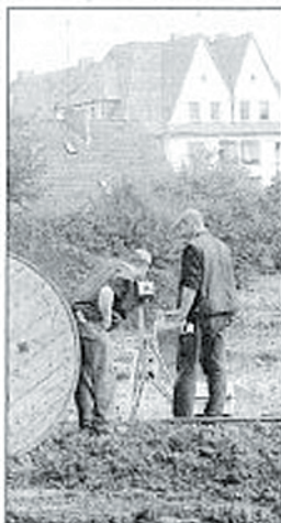
Es kommt auf den Zentimeter an: Vermessungsarbeiten für die ersten 30 Baugrundstücke.
